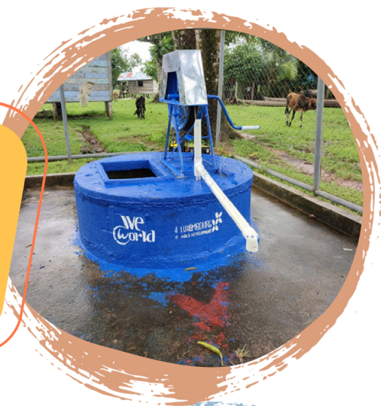
2 Pozos excavado a mano rehabilitados con bomba de mecate
