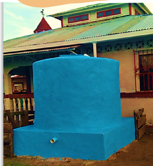
Tanque de ferro-cemento
