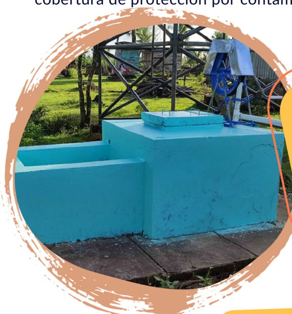
2 Pozos excavado a mano rehabilitados con bomba de mecate
