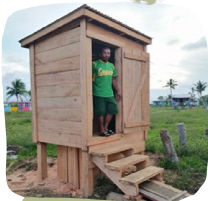
Letrina de fosa estándar sencilla con revestimiento de madera, semi-elevada
