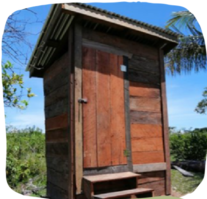
Letrina de fosa estándar sencilla sin revestimiento, semi elevada.
